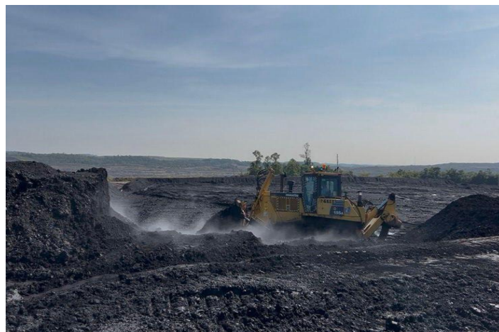
Gambar 6. Penyebaran (Spreading) pada Penanganan Swabakar
