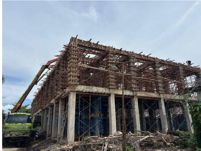
Gambar 6. Pekerjaan Bekisting dan Pengecoran Struktur Lantai Atas
