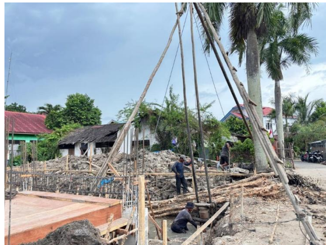
Gambar 1. Pekerjaan Pemancangan
