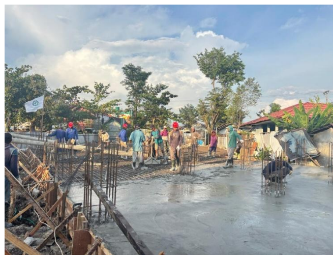
Gambar 4. Pekerjaan Pengecoran Pelat Lantai
