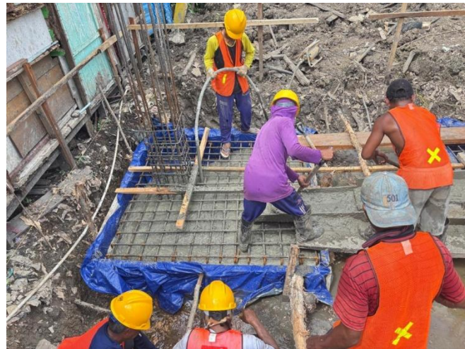
Gambar 3. Pekerjaan Pengecoran Pondasi
