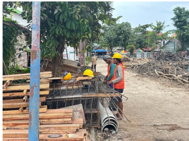
Gambar 2. Perakitan Tulangan Baja (Pembesian)
