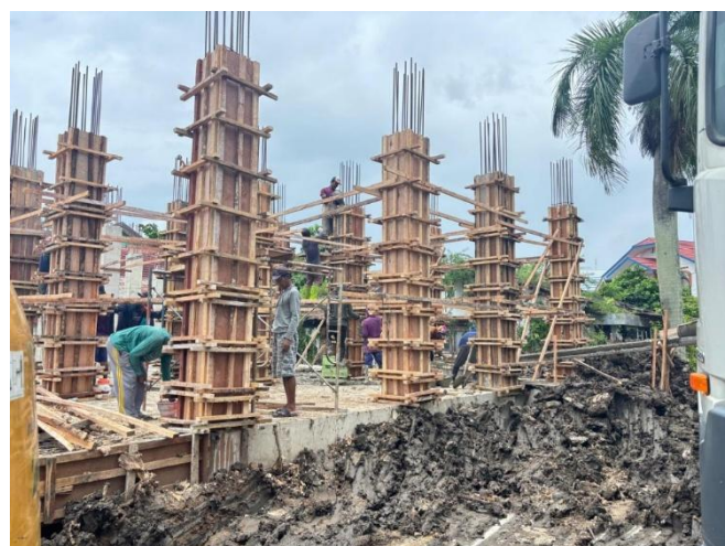
Gambar 5. Pekerjaan Pengecoran Kolom Lantai 1
