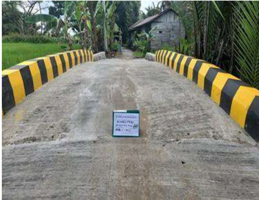
Gambar 18. Progres 100% Pekerjaan Pembangunan Jembatan
