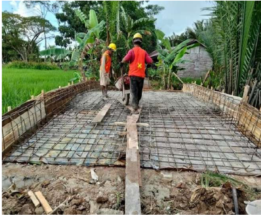
Gambar 14. Progres 50% Pekerjaan Pembangunan Jembatan
