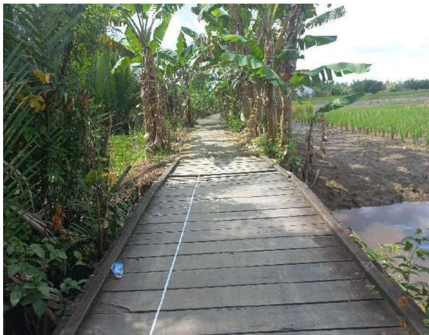
Gambar 8. Progres 0% Pekerjaan Pembangunan Jembatan
