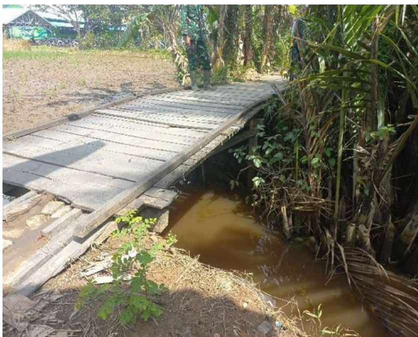
Gambar 9. Progres 0% Pekerjaan Pembangunan Jembatan
