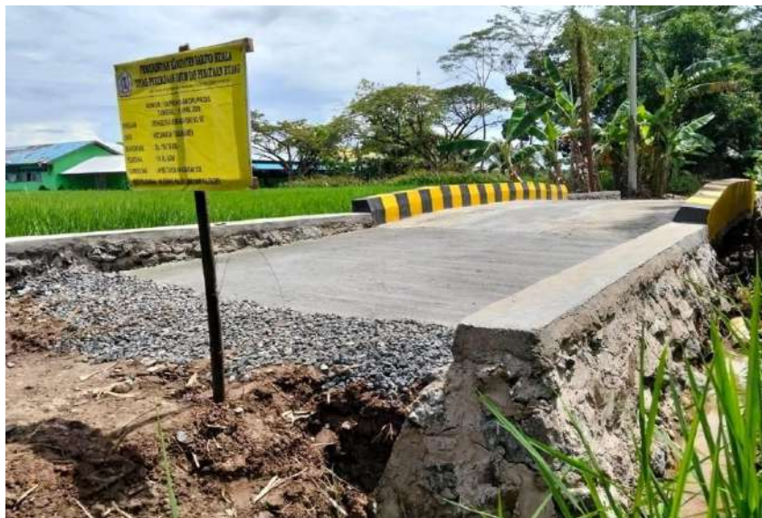
Gambar 19. Progres 100% Pekerjaan Pembangunan Jembatan
