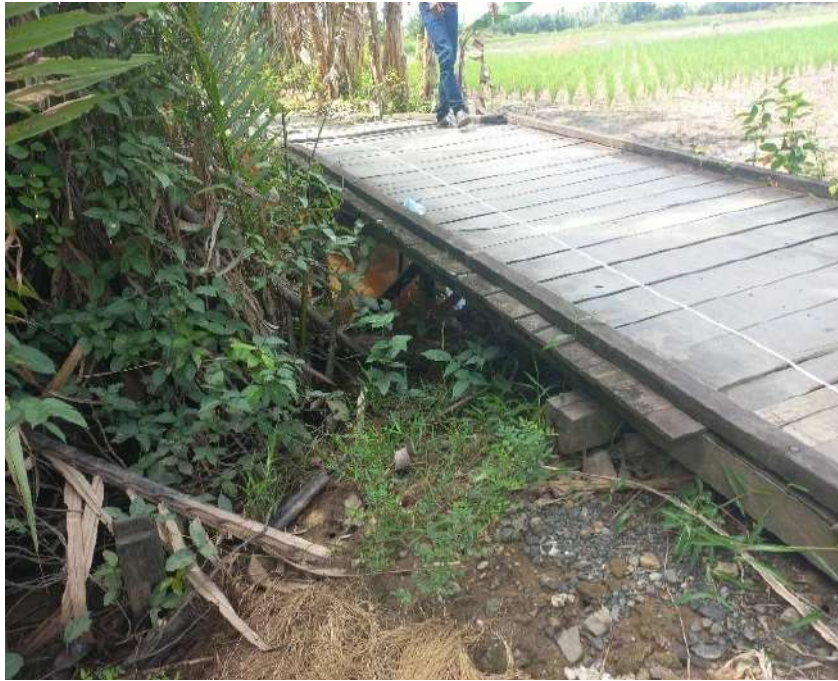
Gambar 10. Progres 0% Pekerjaan Pembangunan Jembatan
