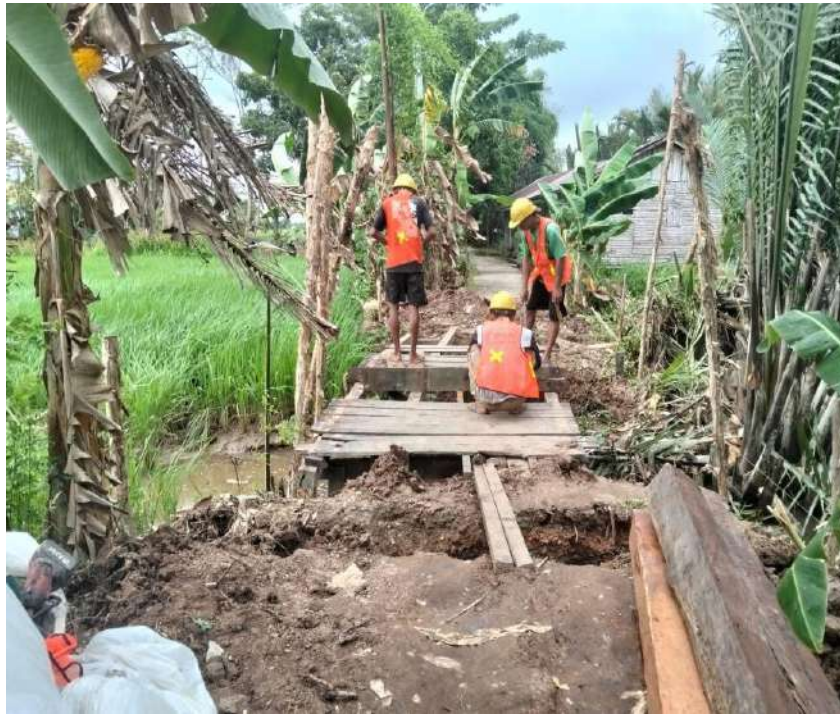
Gambar 12. Progres 50% Pekerjaan Pembangunan Jembatan
