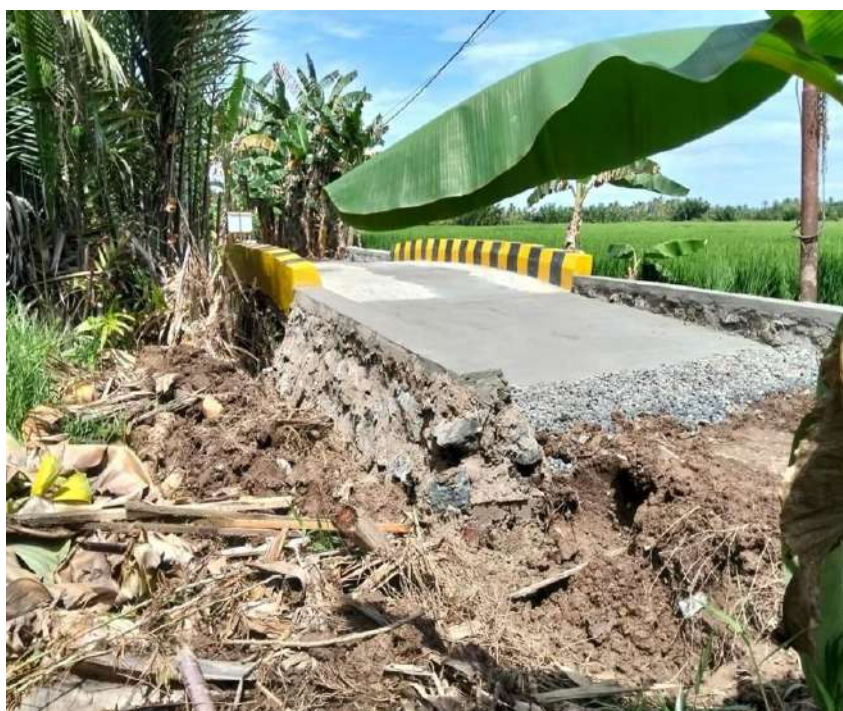
Gambar 17. Progres 100% Pekerjaan Pembangunan Jembatan
