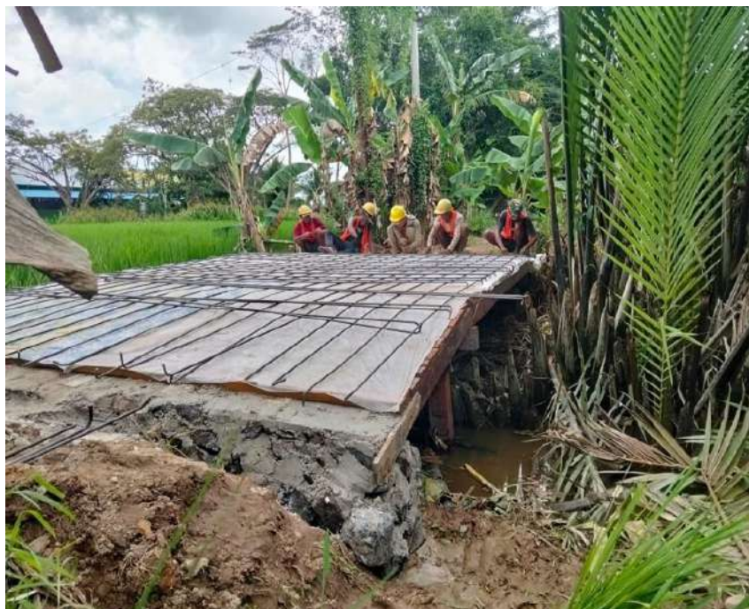
Gambar 16. Progres 50% Pekerjaan Pembangunan Jembatan
