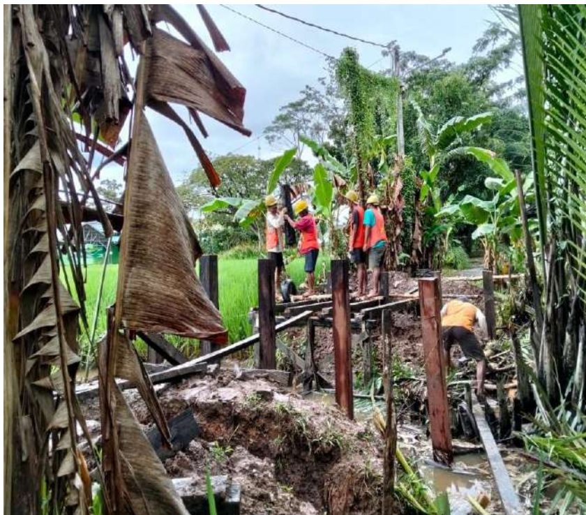
Gambar 13. Progres 50% Pekerjaan Pembangunan Jembatan
